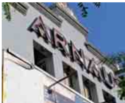
El edificio del Salón Arnau sobrevive.
